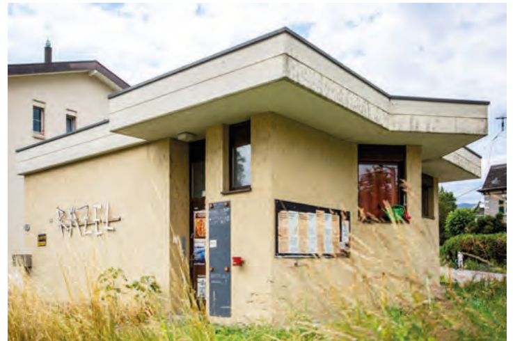
Was im Inneren geschieht, wird aussen angeschrieben.
