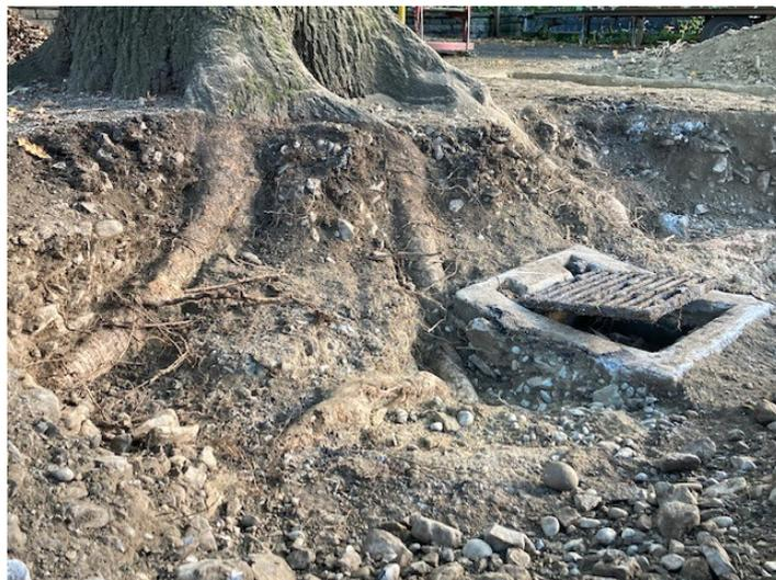
Freigelegter Schacht der Meyerstrasse in einer Tiefe von 55 cm und einer Distanz von 185 cm ab Stammmitte / Derbwurzeln verlaufen in einer Tiefe von 75 cm
