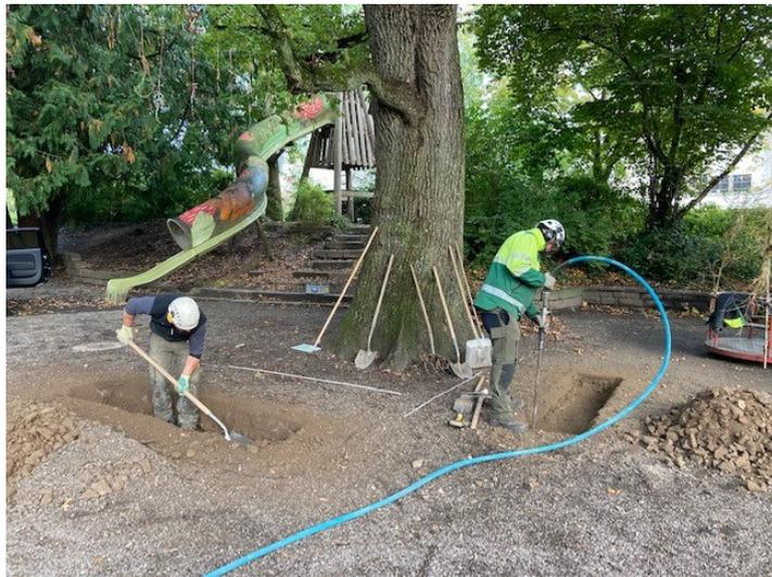
Freilegung des Wurzelbereiches in Handschachtung mit Hilfe einer Drucklanze
