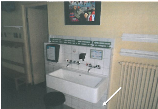
Abb. 15: Nebengebäude: EG, Waschbecken Flur, Kleber Keramikwandplatten, weiss
