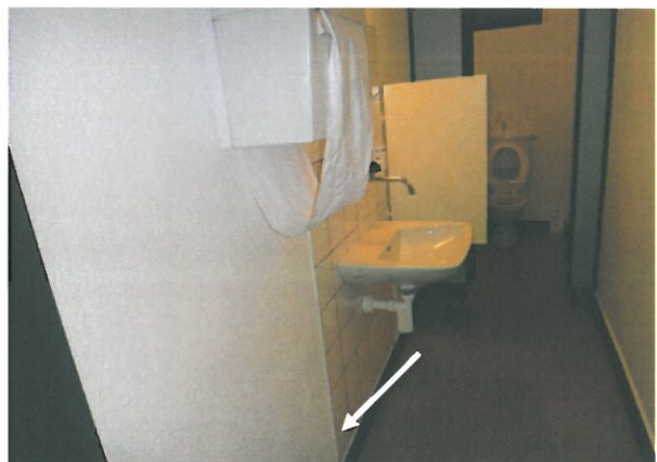
Abb. 6: Pavillon 1: EG, WC, Kleber Keramikwandplatten, weiss
