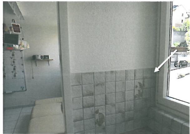
Abb. 14: Nebengebäude: OG, Küche, Kleber Keramikwandplatten, beige
