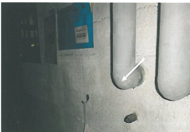
Abb. 11: Nebengebäude, UG, Heizungsraum, Mörtel Rohrisolierung Waschbecken, grau
