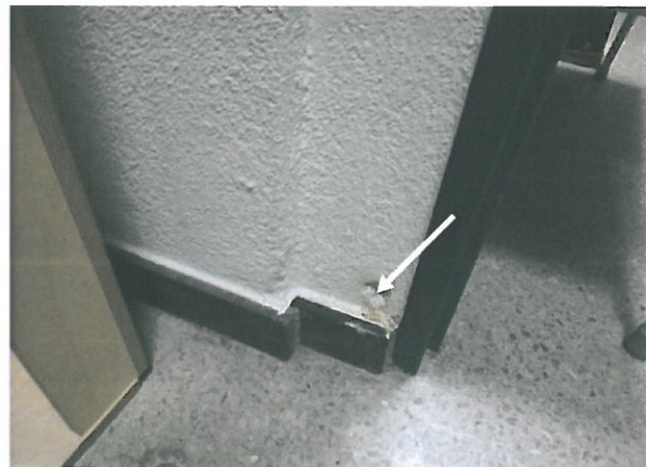
Abb. 8: Pavillon 1: EG/OG, Mischprobe Wandputz
