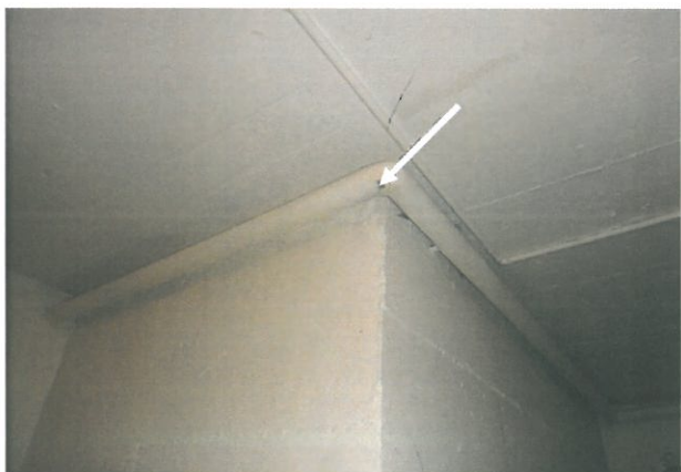
Abb. 17: Pavillon 2: UG, SR/Proberaum, Mörtel Rohrisolierung
