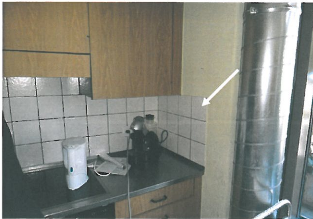
Abb. 7: Pavillon 1: EG, Küche, Kleber Keramikwandplatten, marmoriert
