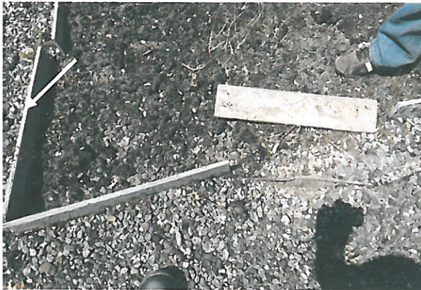
Abb. 37: Pavillon 2: Dach, Stellriemen
