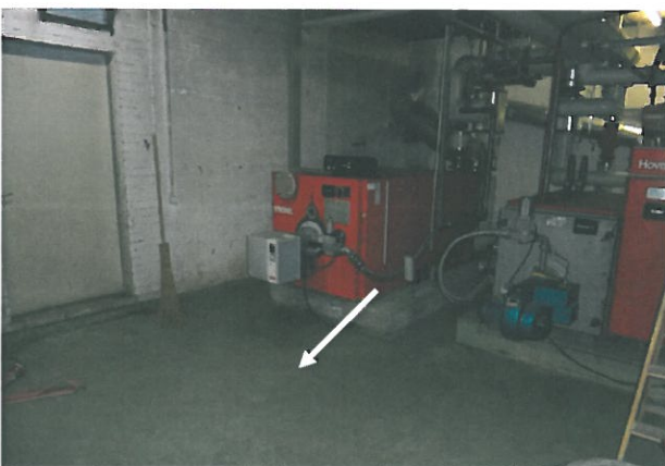
Abb. 27: Nebengebäude: UG, Heizungsraum, Bodenanstich, dunkelgrün
