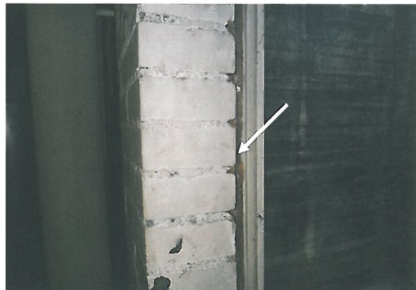
Abb. 10: Nebengebäude, UG, Türe Heizungsraum-Schacht
