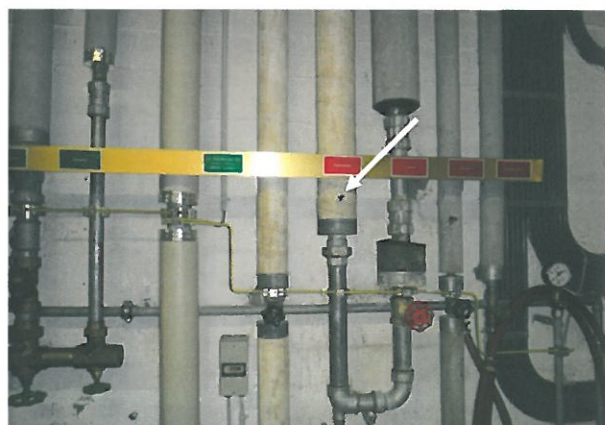
Abb. 12: Nebengebäude, UG, Flur, Mörtel Rohrisolierung Heizungsanlage, weiss
