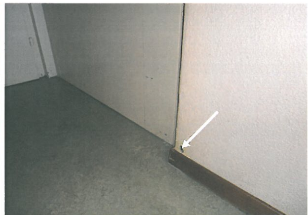
Abb. 16: Nebengebäude: EG/OG, Mischprobe Wandputz
