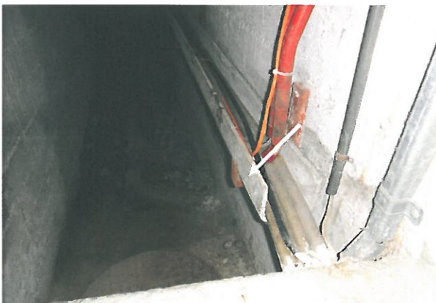
Abb. 23: Nebengebäude: UG, Verbindungskanal, Kabelkanal
