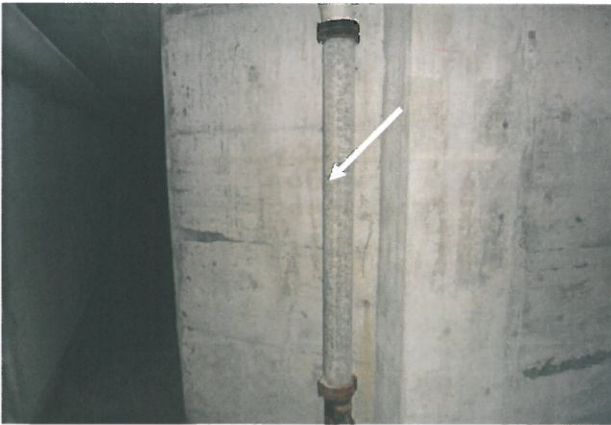
Abb. 3: Pavillon 1: UG, SR/Technikraum, Abwasserrohrre Asbestzement
