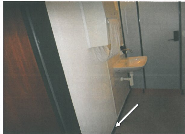
Abb. 20: Pavillon 2: EG, WC, Kleber Sockelplatten, schwarz
