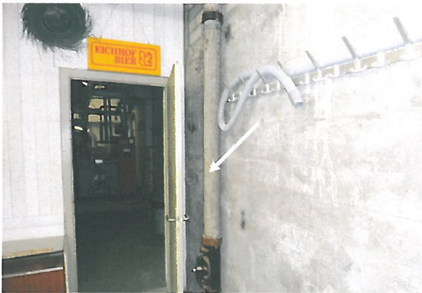
Abb. 21: Nebengebäude: UG, Abwasserrohre
