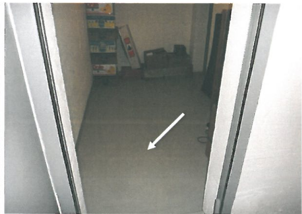
Abb. 32: Pavillon 2: UG, Flur / SR, Bodenanstrich, grau
